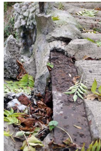
Afb. Brug op landgoed Villa Kanjel in Maastricht, roestende wapening vormt een uitdaging (foto: Michiel van Hunen)
