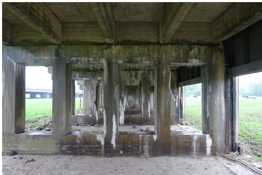
Afb. Schade doorlaatbrug Eldensedijk – Arnhem. (Foto Michiel van Hunen, 2011)
