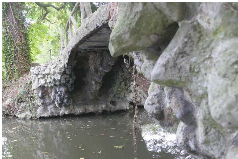
Afb. Brug op landgoed Villa Kanjel in Maastricht, roestende wapening vormt een uitdaging (foto: Michiel van Hunen)
